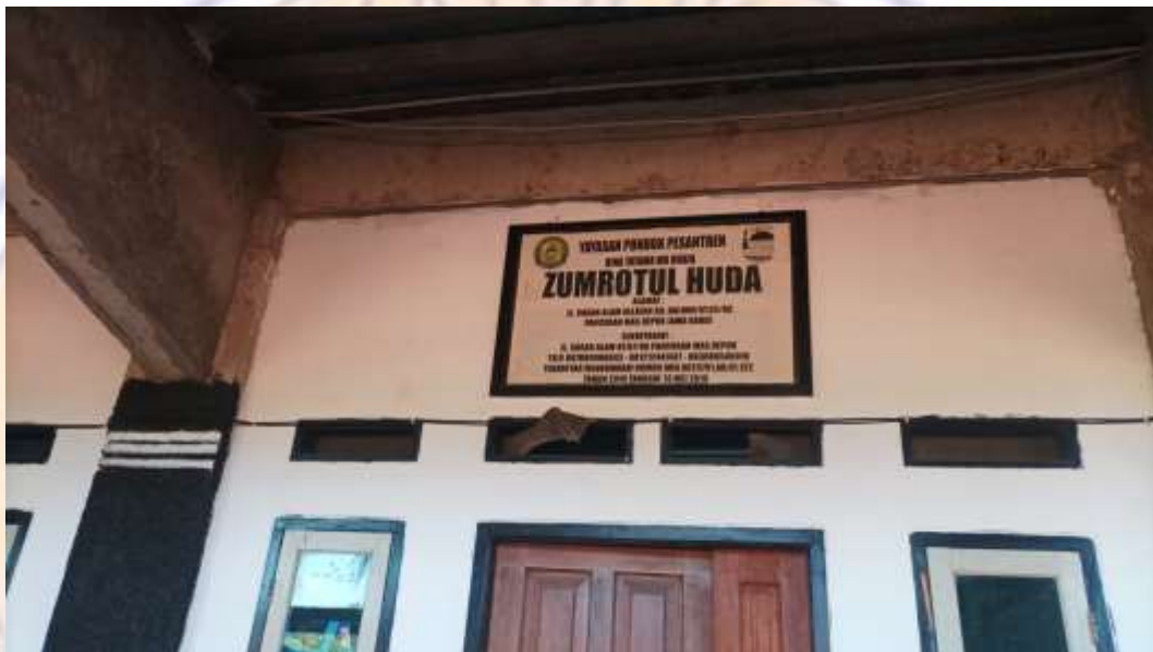
Gambar 1. Bangunan Fisik Pondok Pesantren Zumrotul Huda
