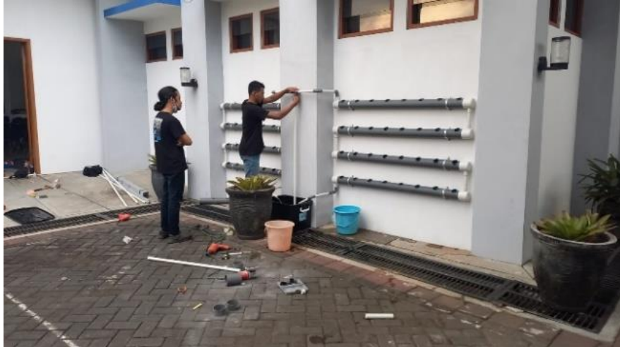
Gambar 1. Pemasangan instalasi hidroponik
